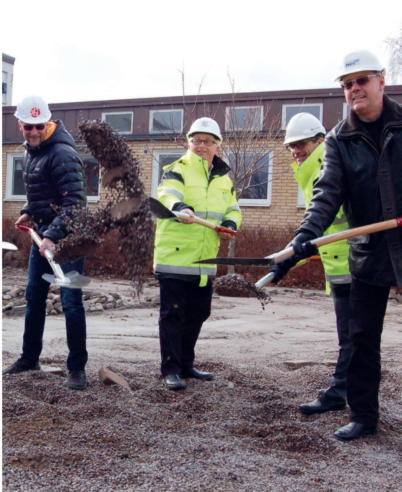
Bygget av nya Torskolan är igång! Första spadtaget togs i februari 2016.
