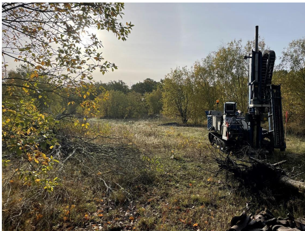
Geoteknisk borrhavn vid Ögat 1, 2
