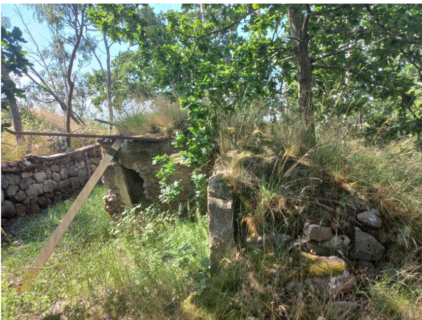
Figur 6. Bild av den främre och bakre skjutvall vid 300 meter. Källa: Sweco, 2022
