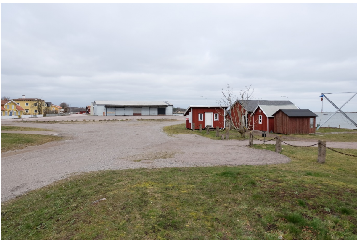
Bild 4 (Nedan): Mellan den bortre hamnbyggnaden i bilden och de röda fiskestugorna stod tidigare den över 30 meter höga spannmålssilon som revs 2019.
