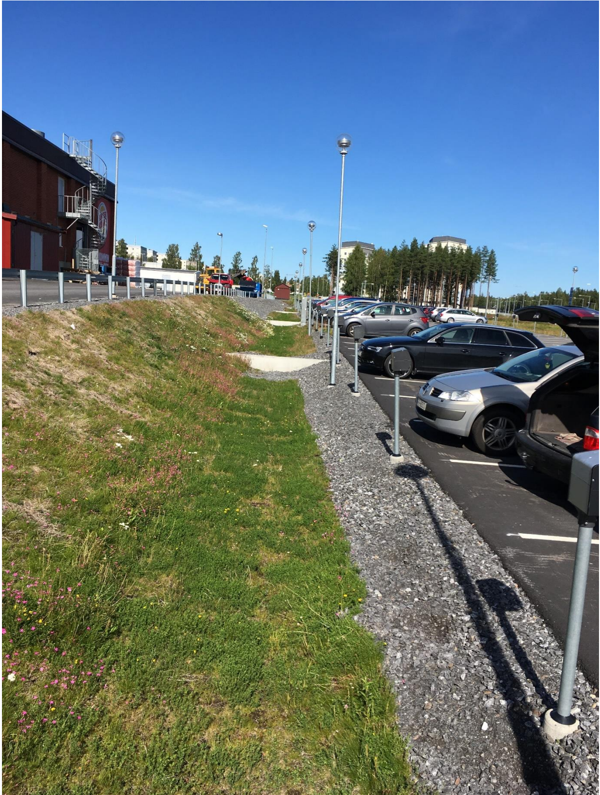
Figur 20. Avledning av dagvatten från trafikytor. Slänten har också funktion som översilningsyta. Foto från Umeå.
