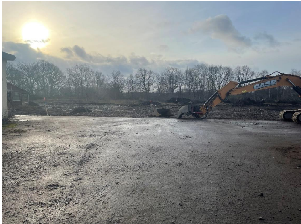
Foto efter genomförd schaktning och sanering av Ögat 1 & 2 med utblick åt söder.
